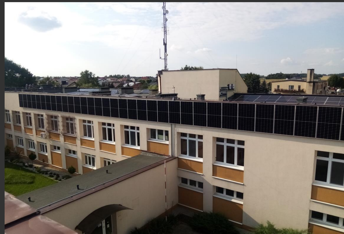
Montaż na elewacji
