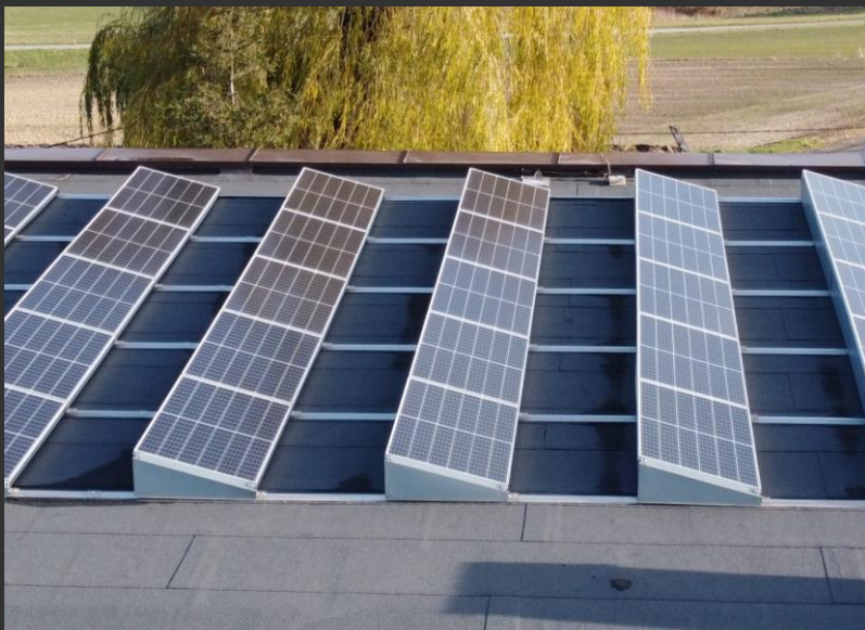
Konstrukcja balastowa aerodynamiczna
